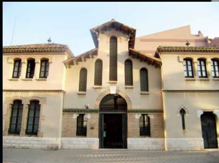
2 Façana de l'antic escorxador de Figueres, obra modernista de Josep Azemar, on està ubicat l'Arxiu Comarcal de l'Alt Empordà
